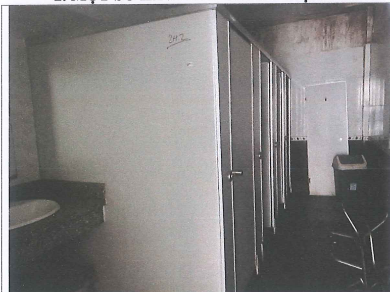
1. PANEL NHÀ VỆ SINH
